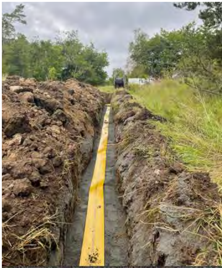
Figur 2. Exempel på ett schakt med uppgrävda jordmassor som tillfälligt läggs längs med schaktet under den korta tid det står öppet. Mängden massor kommer dock att bli mindre i samband med de samrådsanmälda åtgärderna i slätterängen eftersom grässvålen kommer hanteras separat.
