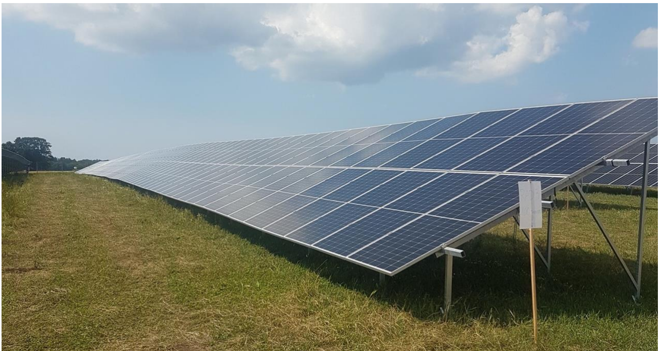
Figur 5, Solpaneler monterade på ställning
