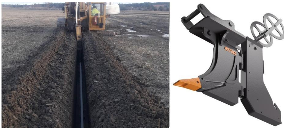
Figur 8, exempel på grävt kabelplog.
