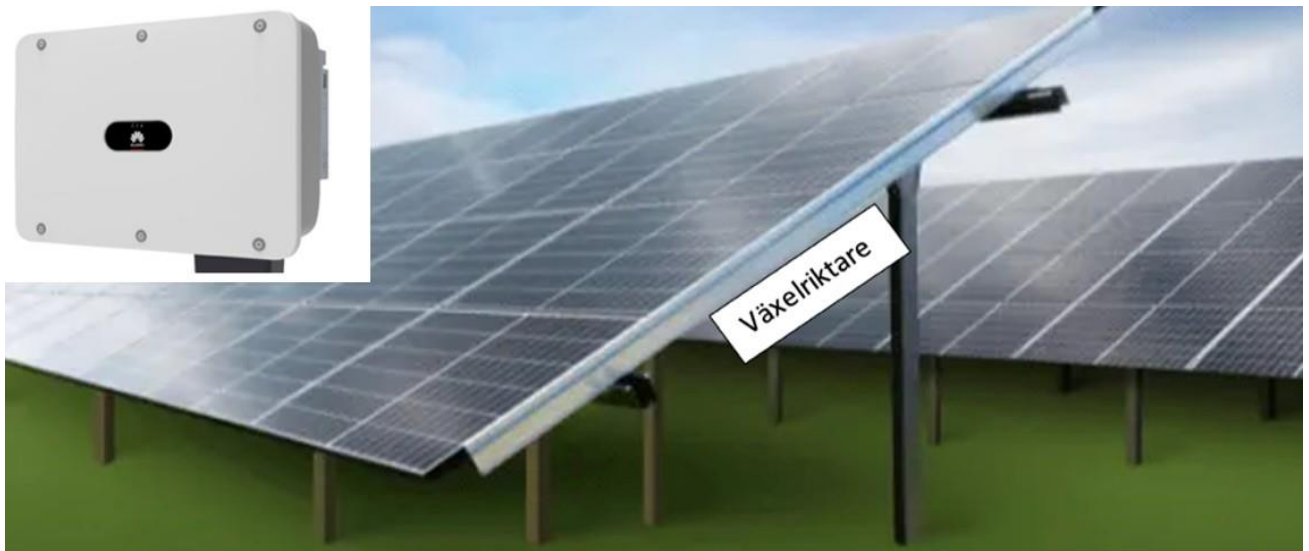
Figur 7, exempel på växelriktare design och placering vilket brukare vara i panelraden längs kanten.
