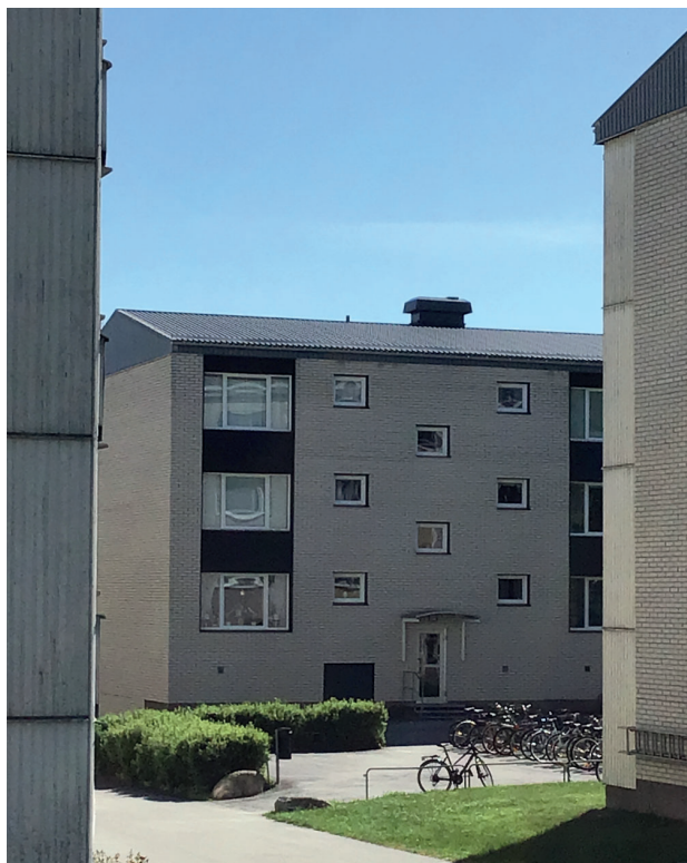
Trevånings lameller på Vigelsjövägen
