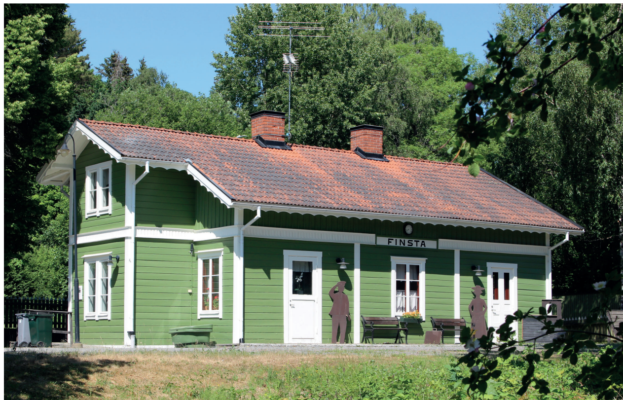
Finsta stationshus utmed spårförbindelsen mellan Norrtälje och Rimbo
