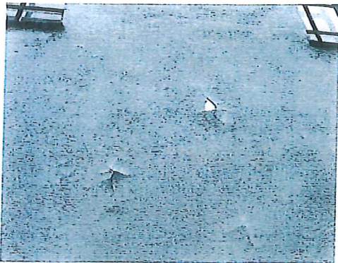
Puts släpper från fasader
