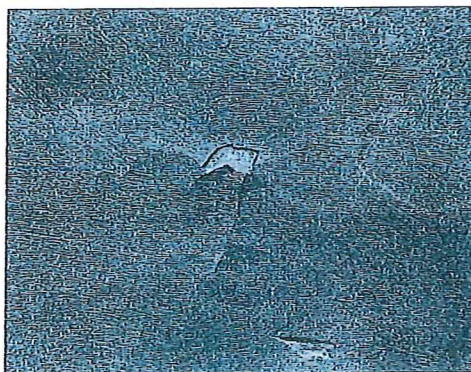
Puts släpper på fasader
