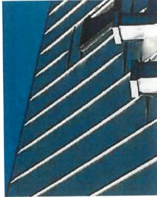
Tak kläs med bandplåt av klarlackerad aluminium.
