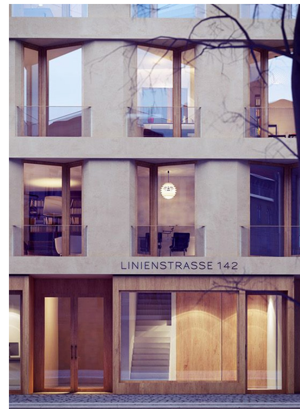
SOCKEL MED AVVIKANDE MATERIAL
