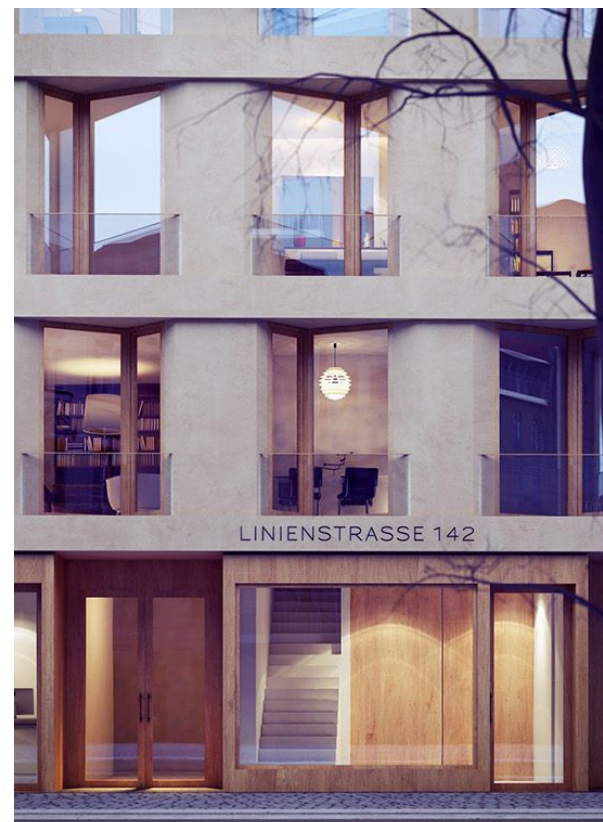
SOCKEL MED AVVIKANDE MATERIAL
