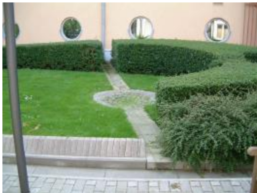
Exempel på ränna för avledning av takvatten. Foto: Norconsult
