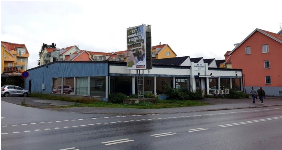
Fastigheten Niord 1 med tidigare bebyggelse, nu riven, vy från Baldersgatan. Foto: Norrtälje kommun.
