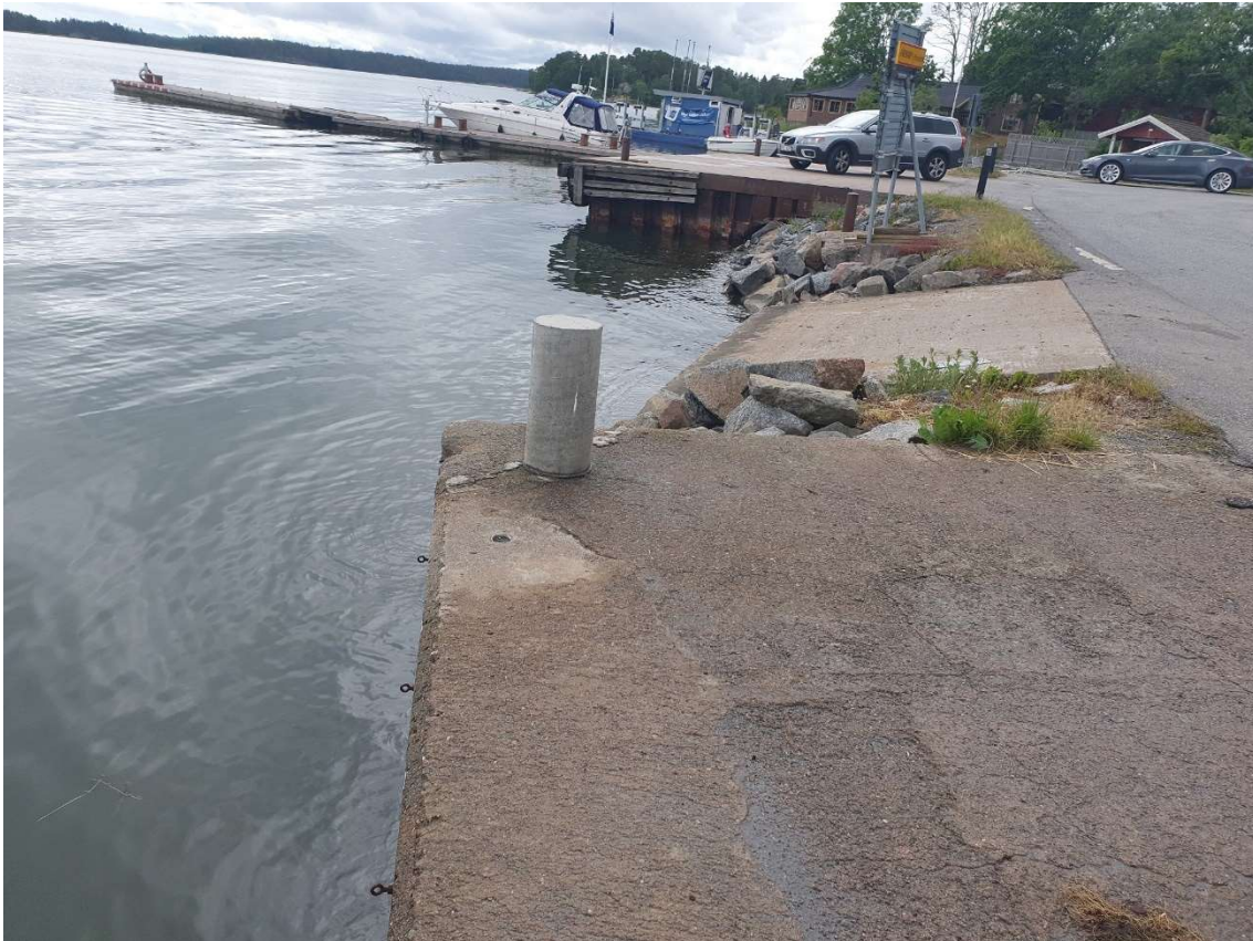
Figur 7. Den ingjutna stenkistan i förgrunden samt fordonsramp i mitten av bild.
