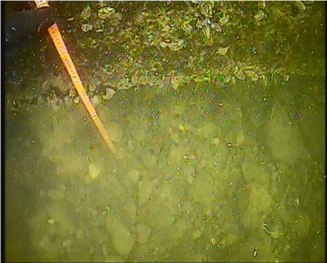
Figur 13. Underspolning pelarpar 10 vänster.
