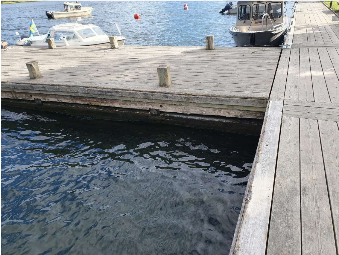
Figur 24. Borråd kaj 2 med pir grundlagd på stenkista.
