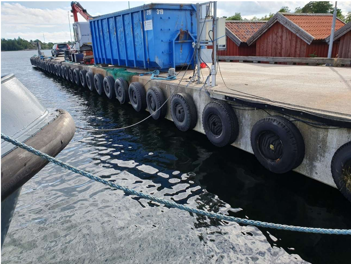
Figur 11. Betongkaj 1 med långsida mot öster. Används bland annat av sjöräddningen samt sopbåtar.
