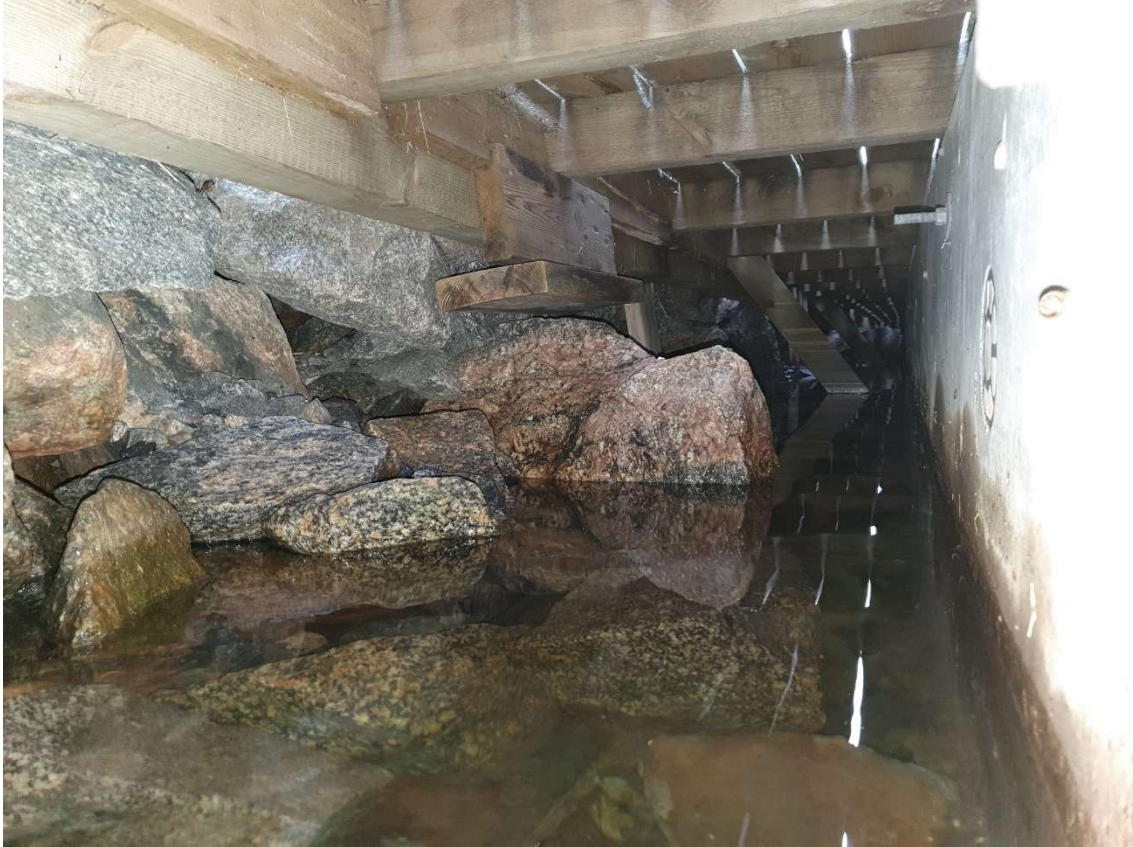
Figur 23. Bakom Borrade kaj 1 där sektion 4 slutar.
