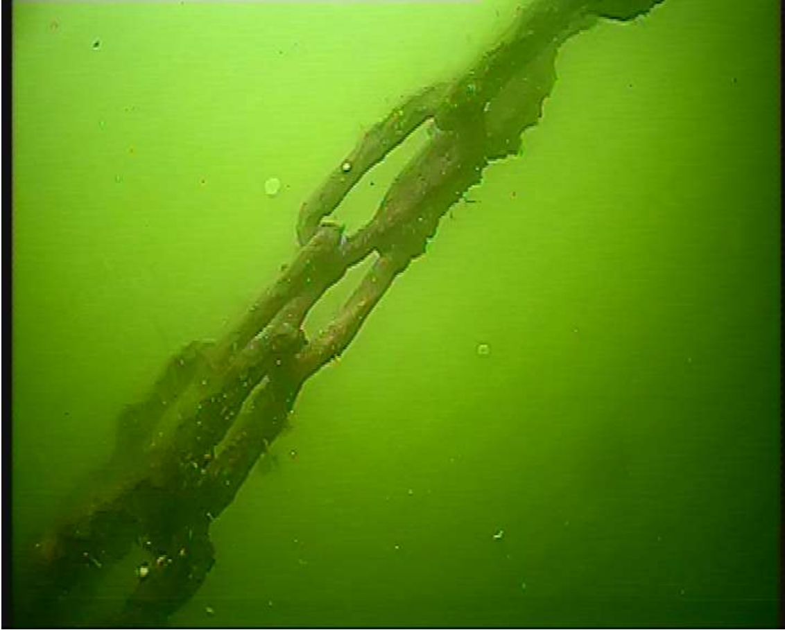
Figur 4. De två yttre kättingarna på yttre bryggan. Slitna där de ligger mot varandra.
