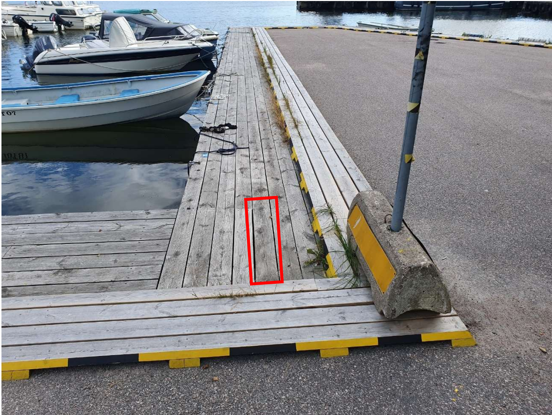
Figur 22. Däcksplanka, inramad i rött, känns mycket mjuk. Den vänstra intill är utbytt.
