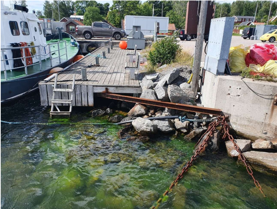
Figur 10. Träbryggan med diagonal H-balk svetsad i kättingfäste till höger.
