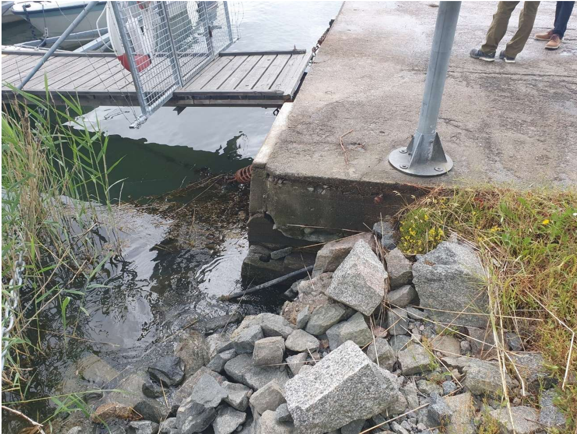
Figur 8. Delar av den ingjutna stenkistan syns i norra hörnet.
