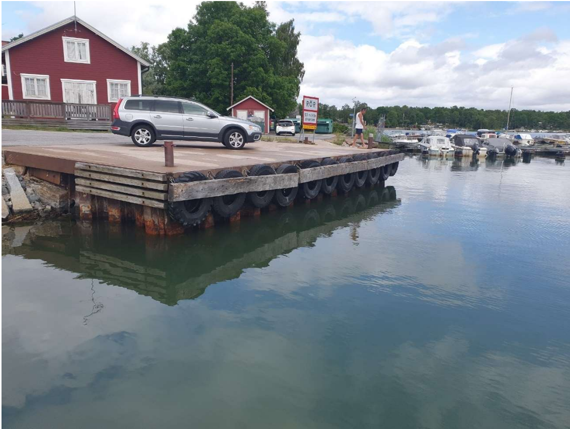
Figur 5. Lastkaj utförd med spont.
