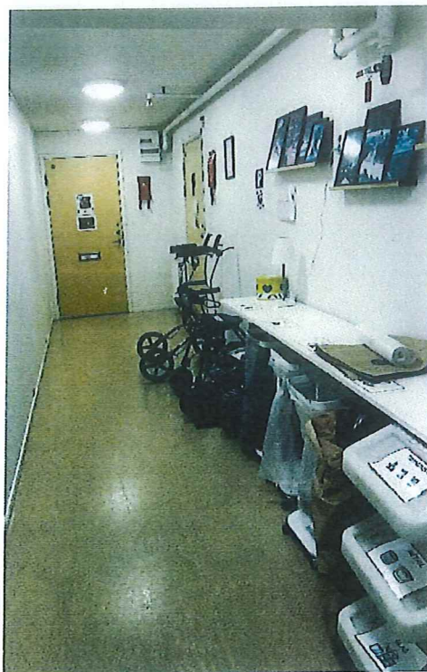
Figur 4 Förvaring av brännbart material.
