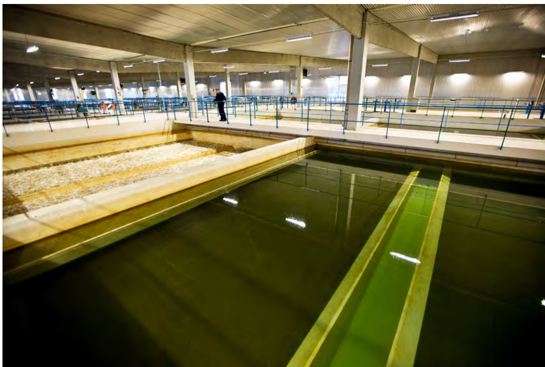
Foto: Kari Kohvakka, Stockholm Vatten och Avfall
