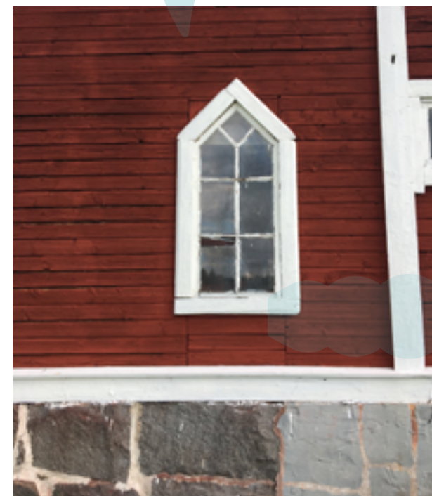
Fönster på ekonomibyggnad i Adamsberg. Fönstret har Löfvenskiölds ritningar som förlaga. Foto: WSP, 2019.
