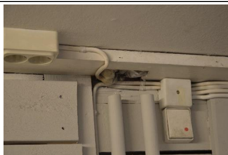
Figur 3 Bilden visar ett exempel på håligheter i taket
