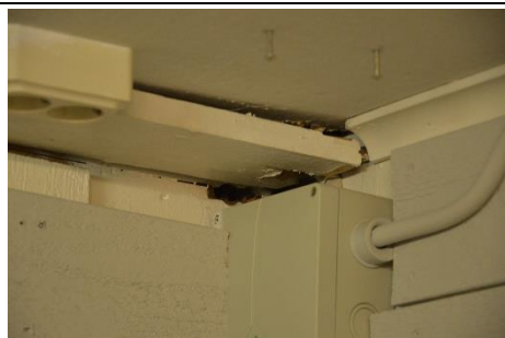
Figur 4 Bilden visar ett exempel på håligheter i taket
