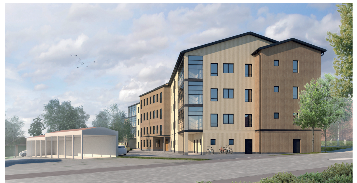
Vy från norr mot vård- och omsorgsboendet
