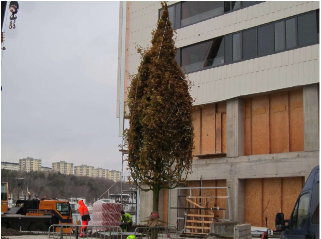
Figur 4. En ek ( Quercus robur ) med en stamomkretsstorlek på 60-70 cm. Trädet på bilden är uppbundet för att minska risk för skador på grenar och krona under transport.
