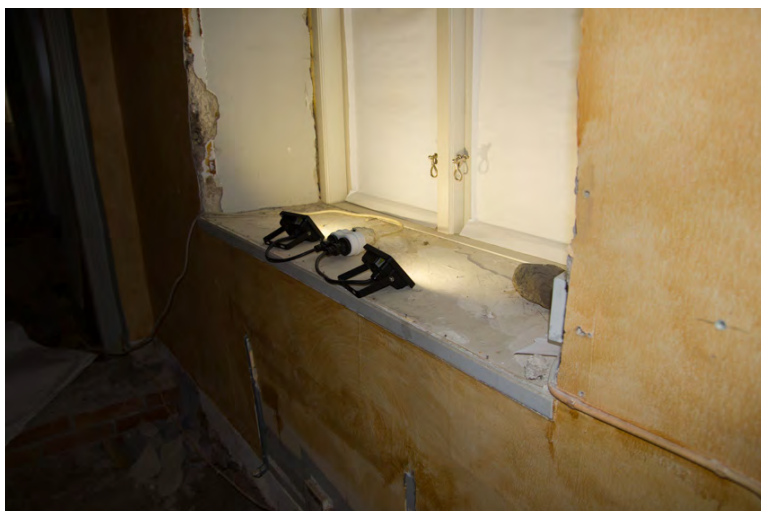
Äldre fönsterbänk av trä. Nya fönster monterades 2017.
