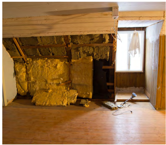
Vindsväggarna har varit inklädda med panel som döljer murkrön och takstolar. Mineralullsisolering ses bakom frilagda väggpartier.
