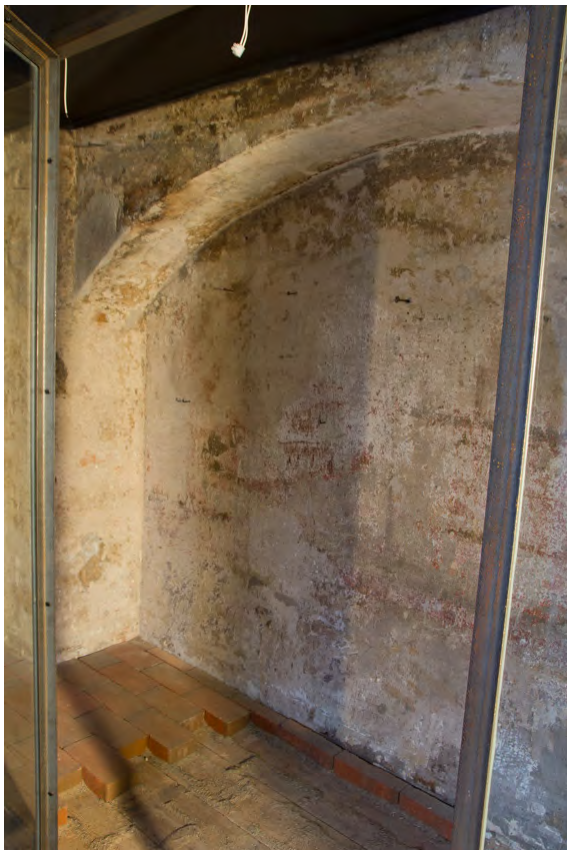
Putsat och murat valv som bär upp rökkanalerna till skorsten.
