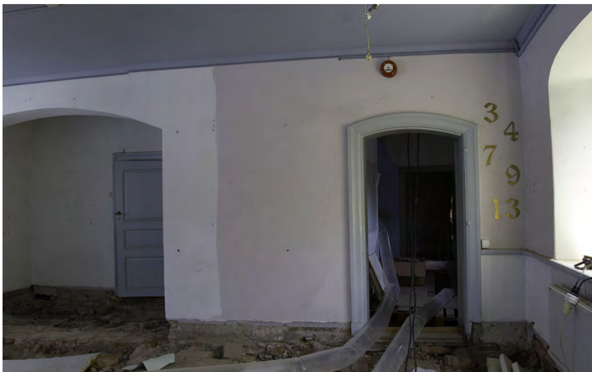
Vålvd dörröppning mot rum 11 med kraftiga dörrfoder i empirestil och ålderdomlig bräddörr. Äldre bröstlist finns kvar i delar av rummet.
