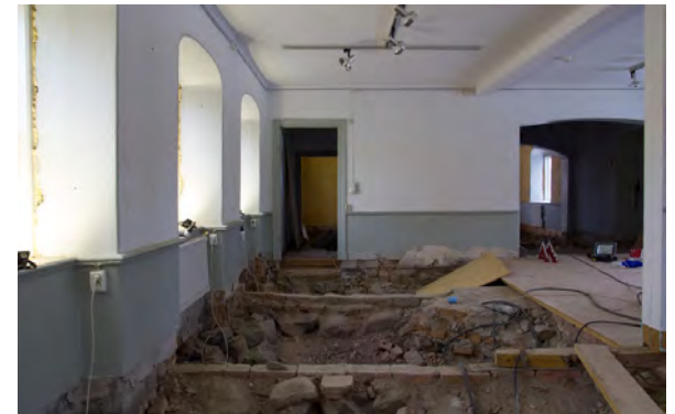
Foto av norra delen av rummet med tvärgående sten- och tegelmurar samt eldstadsfundament.
