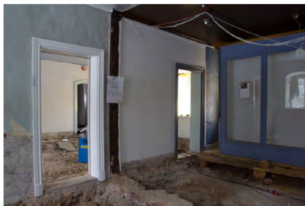
Till höger finns en utställningsmonter kvar och delar av det gamla bjälklaget.
