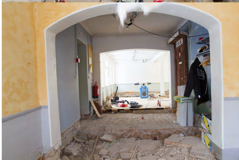
I förgrunden till höger ses eldstadsfundamentet i tegel. I fonden ses rum 6.
