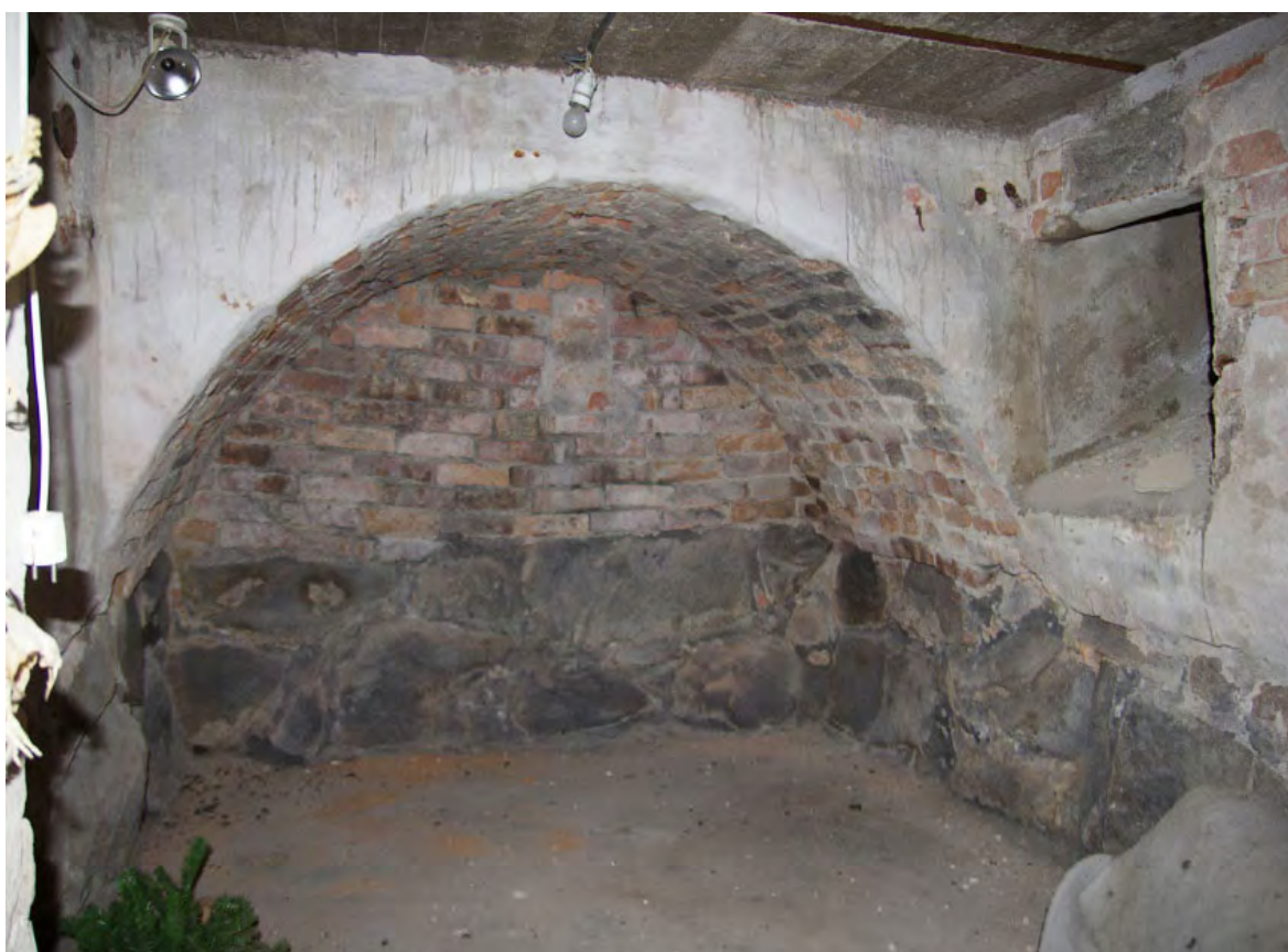
Västra källarens främre del har gjutet betongtak. Där har tidigare funnits ett pannrum.
