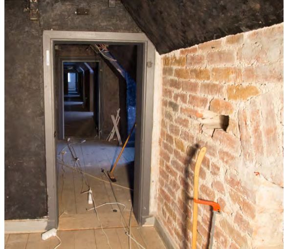
Tegelväggen frilagd på södra muren.
