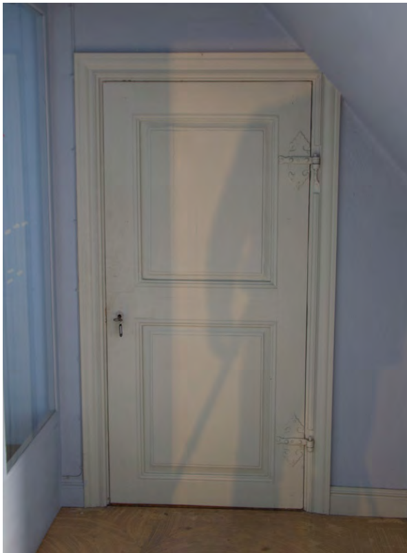
Dörr med ålderdomliga gångjärn av 1700-talstyp.
