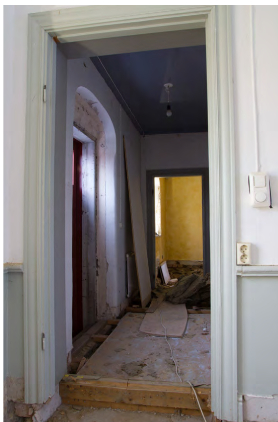
Ovan och ovan till höger: Foto mot öster med rum 3 i fonden. Golvet är rivet men bjälklaget ligger kvar under plywoodskivan. I förgrunden på högra bilden ses dörrfoder och bröstpanel i rum 7 och den nya pardörren mot Hantverkaregatan skymtar.
