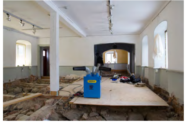
Foto mot öster mot.
