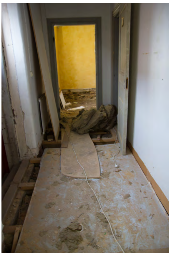
Ovan och ovan till höger: Foto mot öster med rum 3 i fonden. Golvet är rivet men bjälklaget ligger kvar under plywoodskivan. I förgrunden på högra bilden ses dörrfoder och bröstpanel i rum 7 och den nya pardörren mot Hantverkaregatan skymtar.
