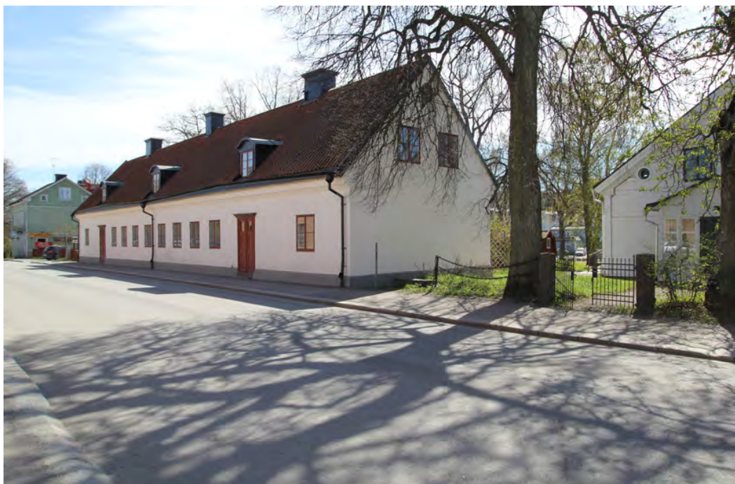
Fasad mot Hantverkargatan efter 2017 års fasadrenovering.
