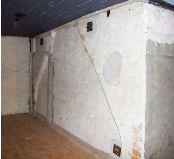
Putsad vägg mot murstock.
