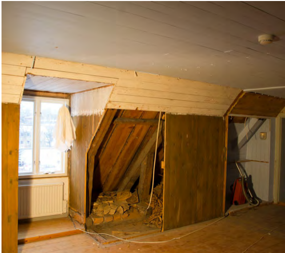
Vindsväggarna har varit inklädda med panel som döljer murkrön och takstolar. Mineralullsisolering ses bakom frilagda väggpartier.
