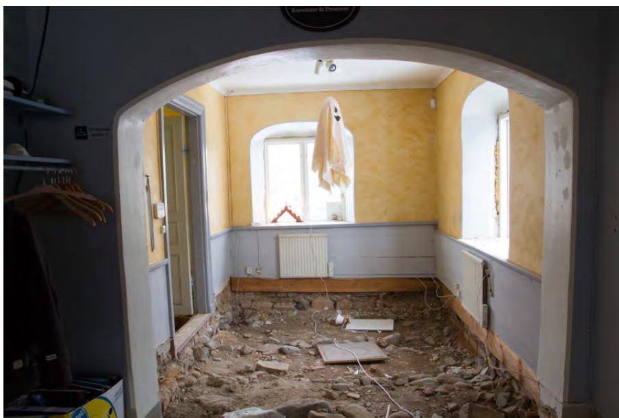
Foto mot öster. Detta är det enda rum som har en bröstpanel av trä under den profilerade bröstlisten som är hopfogad med fönsterbänkarna.
