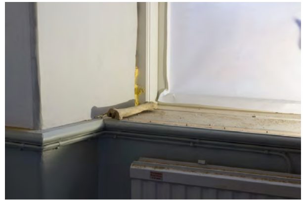
Fönsterbänk och bröstlist, troligen från 1920-talet.
