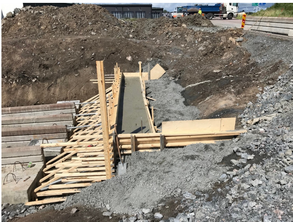
Gjutning av 1x1x6 meter betongblock för att säkra initial riktning av borrhningen.
