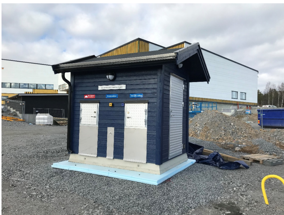
Norrtäljes första vattenkiosk! Kulören är Norrtälje-blå. Har även försetts med ett sedum-tak.
