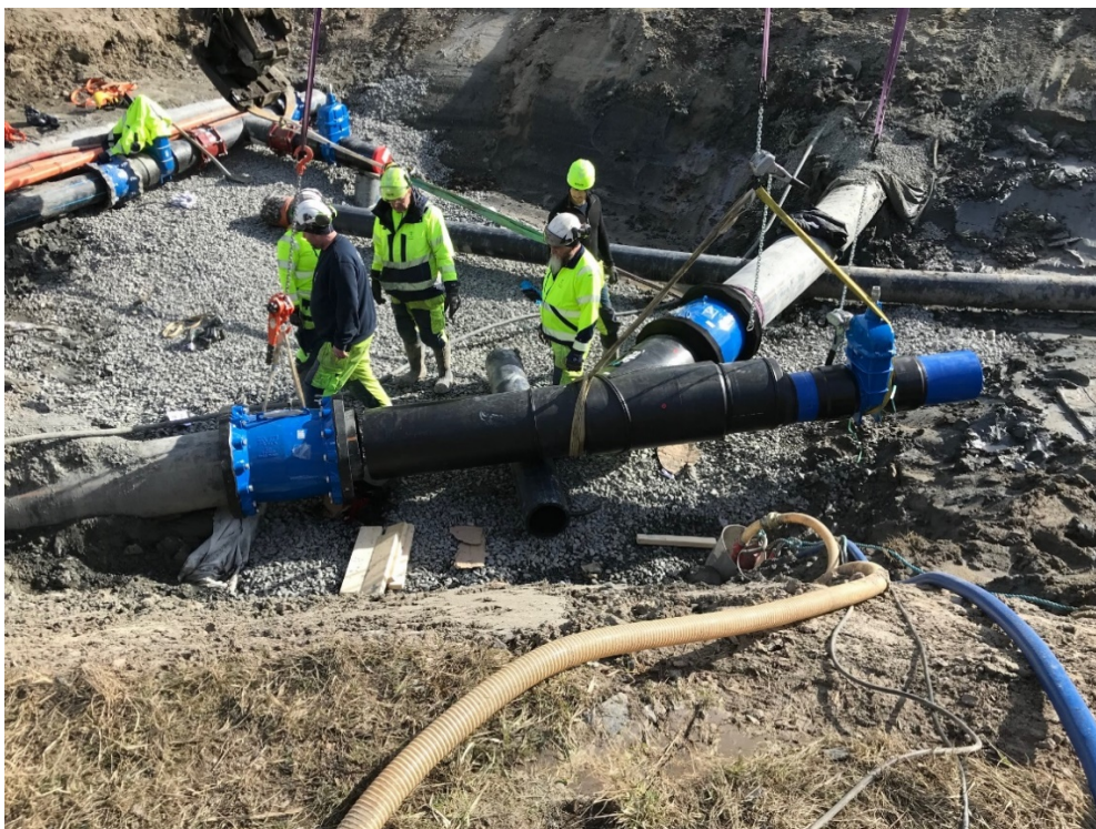
Specialtillverkat grenrör som lyftes på plats med hjälp av kranbil.
