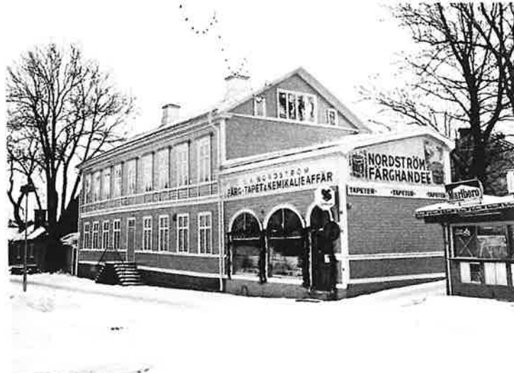
1984 är taket troligen ljusgrått och entrén mitt på fasaden åter upptagen.
