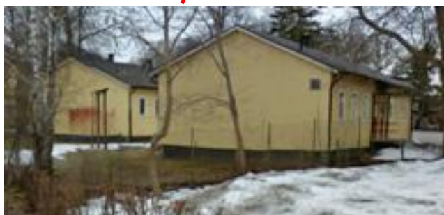
Brännasskolan 2 st baracker
